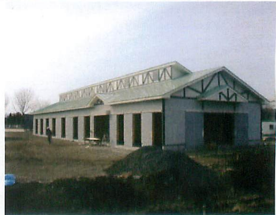
建設中の厩舎
